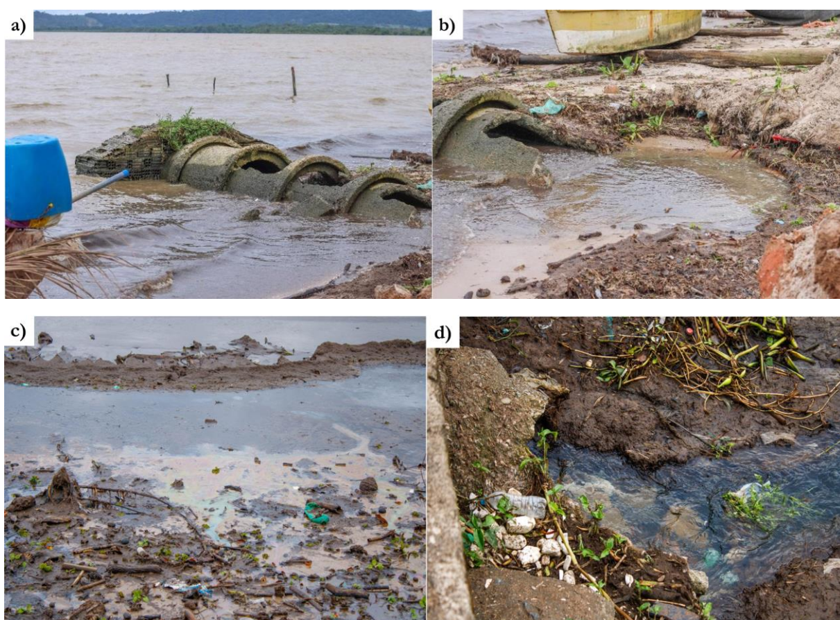
Figura 2 - Lançamento de esgoto e presença de óleo na superfície da água.
